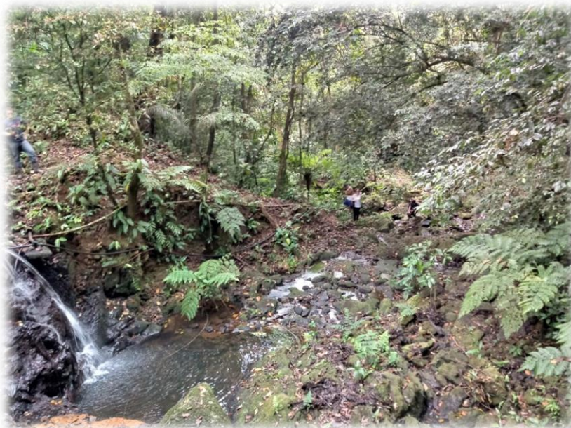
Vista do vertedouro da barragem de contenção da represa – Imagem: COMTUR
