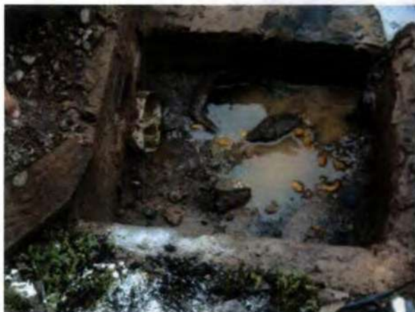
Vista de caixa contendo esgotos
