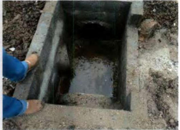
Caixa de águas pluviais
