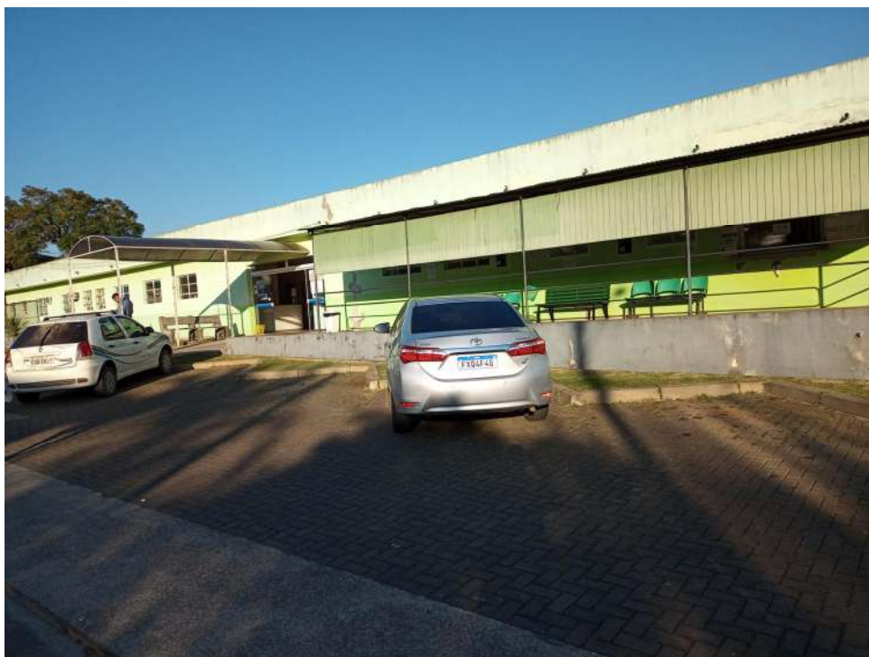
Foto 01 – Local de Trabalho
