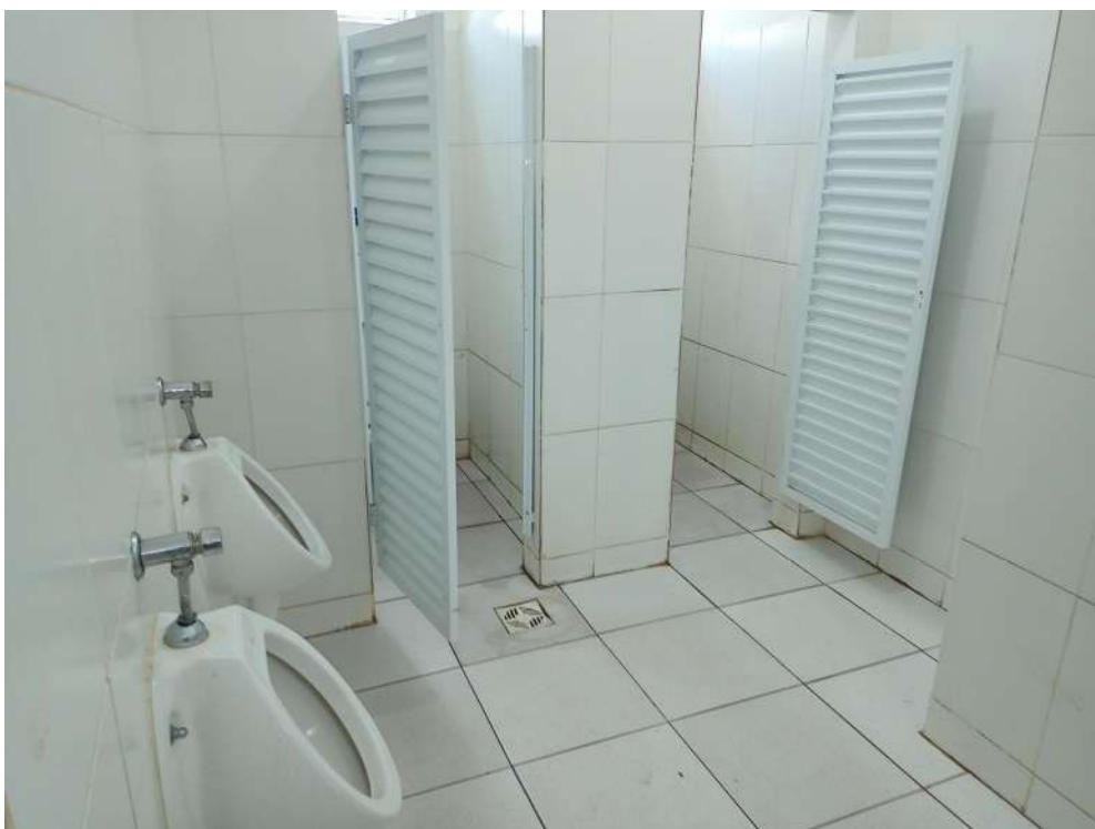
Imagem 02 – Banheiro Masculino da Estação Rodoviária
