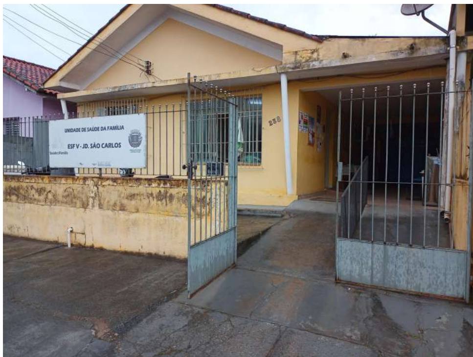
Foto 01 – Local de Trabalho
