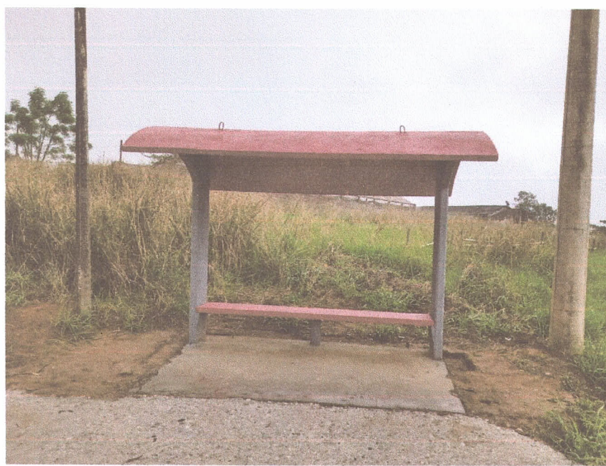
Estrada do Boa Vista, PA 08 - Bairro Boa Vista Coordenadas: 0217149, UTM 7276236.
