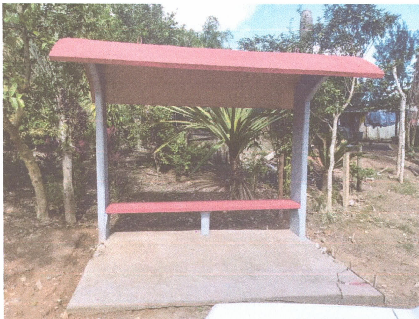
Estrada do Cacau Açu, PA 26 - Linha 13 de Maio Coordenadas: 0209369, UTM 7262725.
