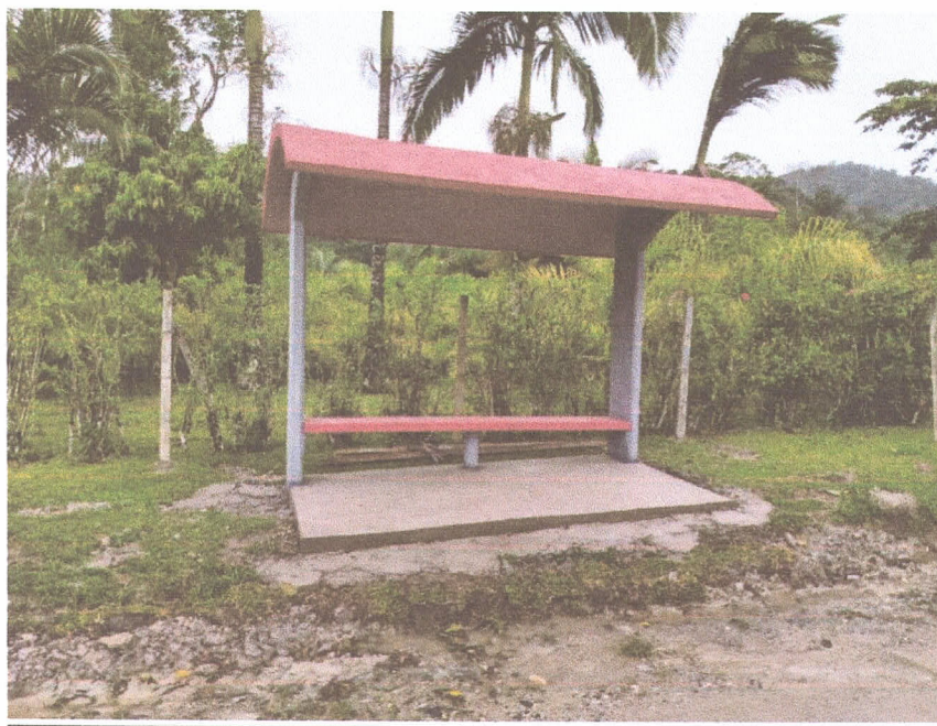
Estrada do Braço Grande, PA 21 - Bairro Braço Grande Coordenadas: 0207371, UTM 7258307.
