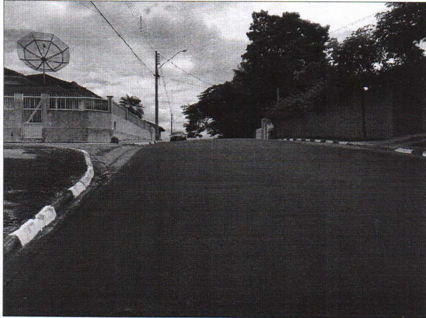
Rua André Rossini (próximo à esquina com a Rua Alexandre Rangel), na Vila Roseli.
